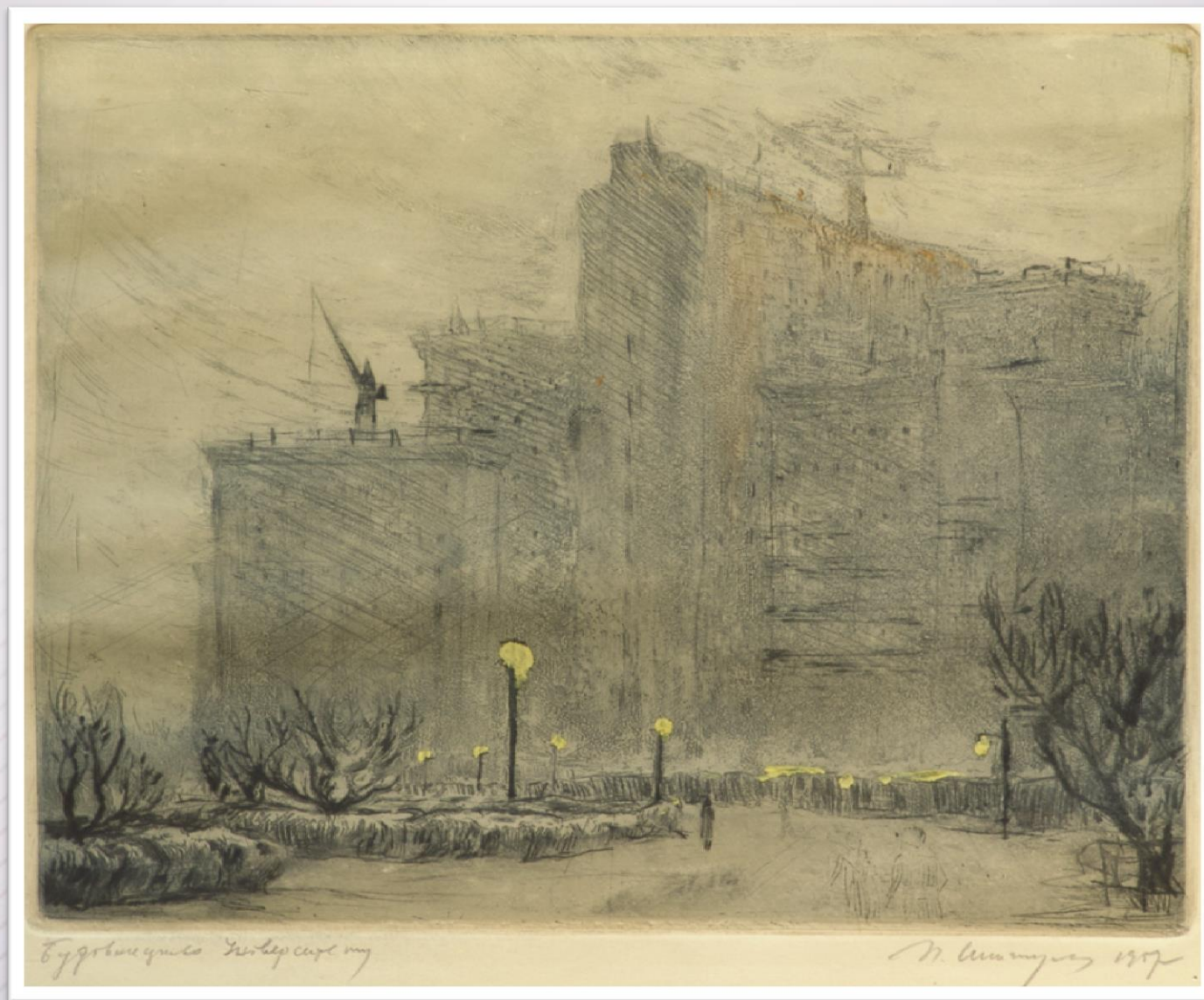
Шигима П. А. Будівництво університету. 1957.
